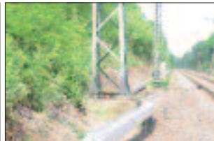
Aufgeständerter Kabelkanal (Eisenbahnen)
